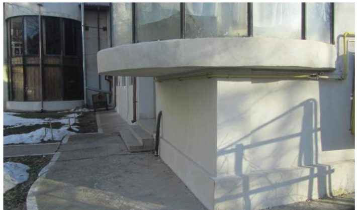
Refacere tencuială și zugrăvit parter corp administrativ
