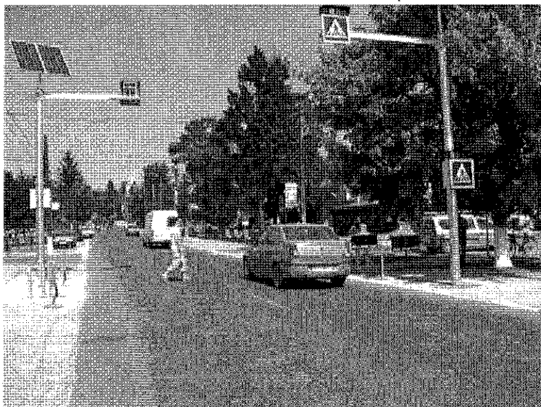
Fig. 16. Exemplu de sistem de detectie si semnalizare a trecerilor de pietoni
