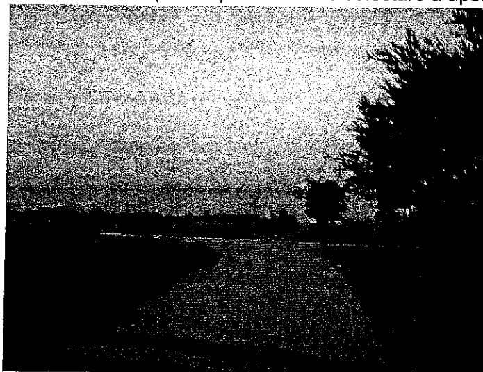
Fig 11 -12 Partea carosabila pietruita a drumului judetean DJ 203E in zona localitatii Cocora. Se observa colmatarea sau lipsa dispozitivelor de colectare a apelor pluviale
