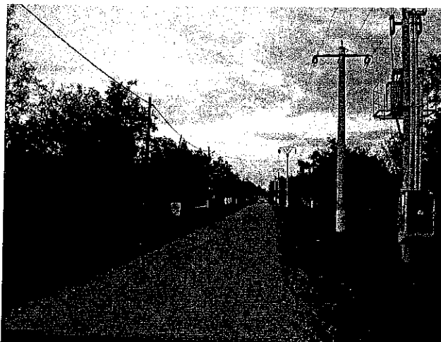
Fig 11 -12 Partea carosabila pietruita a drumului judetean DJ 203E in zona localitatii Cocora. Se observa colmatarea sau lipsa dispozitivelor de colectare a apelor pluviale
