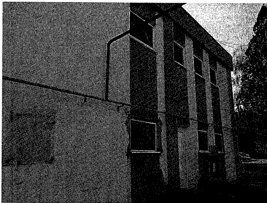
Figura 31 - Fațadă DGASPC Ialomița
