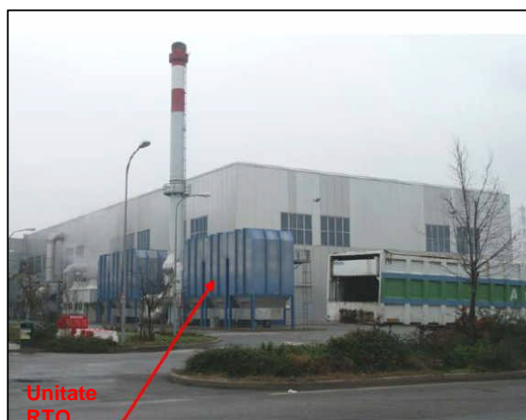
Figura 20: Bioscarea deseurilor cu unitate RTO
